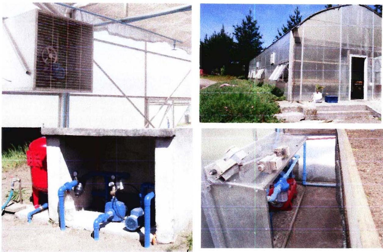
**Figura 29: ARRIBA: Extractor de aire y sistema de desplazamiento de malla térmica superior (izq.); ventanas laterales reparadas (der). ABAJO: Motobomba exterior reparada (izq.); Sistema de dosificación de agroquímicos incorporado a la línea de riego (der).**
