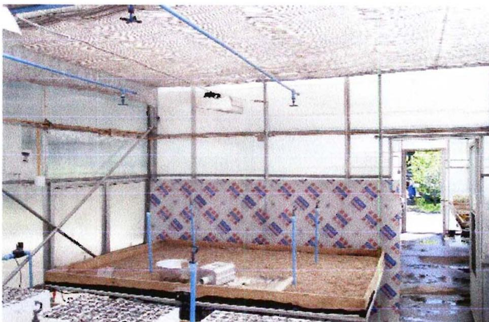
**Figura 31: Reposición de los regadores en mal estado y reparación de las líneas de riego y reparación equipo de neblina**
