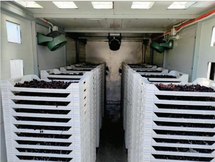
**Figura 9.** Vista interior CDS dos ventiladores axiales y 3 de recirculación interna.
