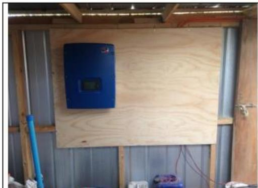
Inversor Trifásico SMA 5k montado.
