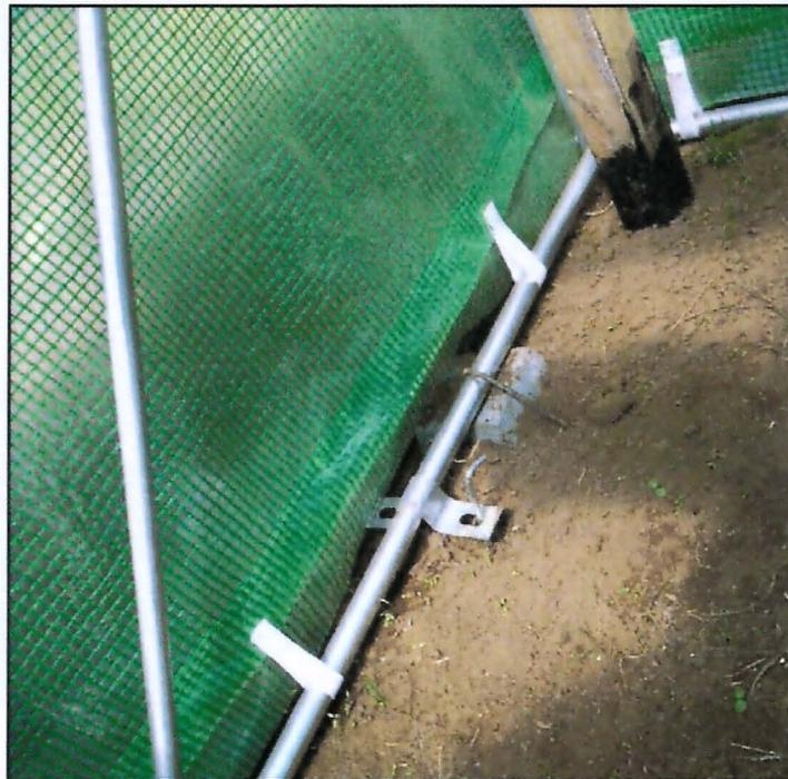
**Figura 7:** Detalle Anclaje al Terreno con cubo o pollo de cemento
