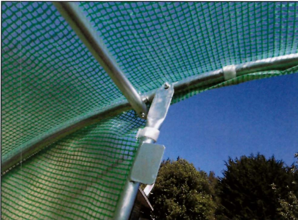
**Figuras 5:** Detalle estructura metálica galvanizada tubular y malla protectora cuadrículada incorporada
