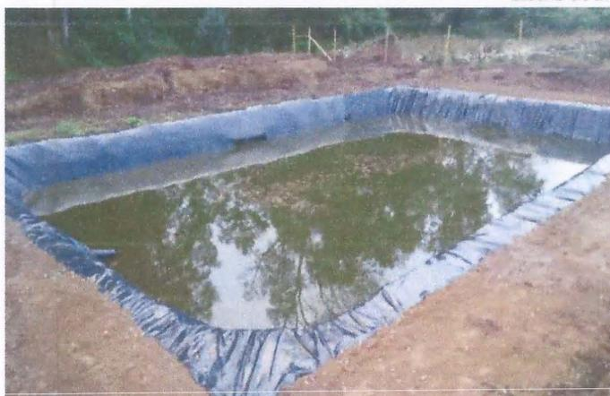
**Figura 9: Acopio impermeabilizado con Geomembrana para digestado, tamaño 250m<sup>3</sup>.**
