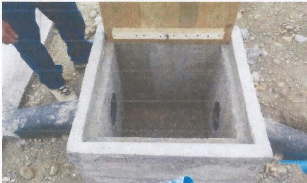
**Figura 13: Instalación Red de tuberías en Decantador y Biodigestor**
