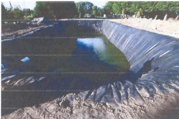
**Figura 14: Impermeabilización de pozo purinero**
