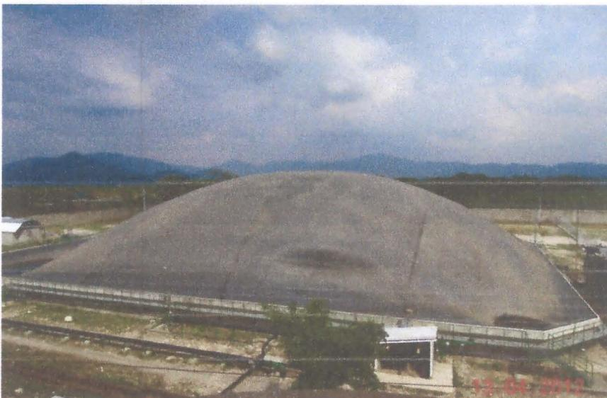
**Figura 29: Biodigestor tipo Laguna, Geomembrana Caucho Superior.**
