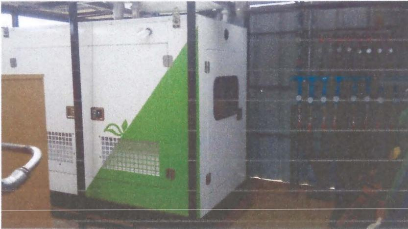
**Figura 20: Grupo Electrónico 31kVA adaptado a Biogás. Fuente Biotecsur.**
