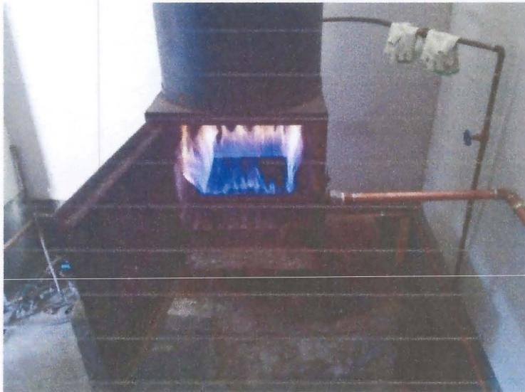
**Figura 5: Caldera a Biogás de un SPB. Fuente Biotecsur**
