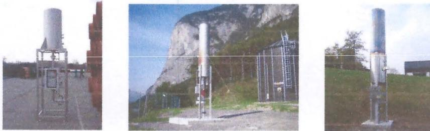
Figura 36: Ejemplos de antorchas para Biogas.
