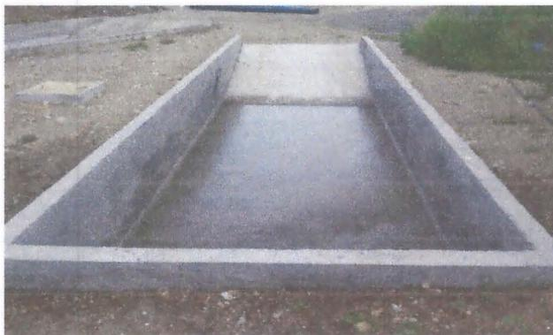
**Figura 12:** Construcción Decantador de hormigón
