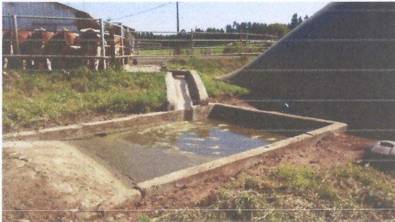
**Figura 24: Decantador de en Sistema de biodigestión. Fuente Biotecsur**
