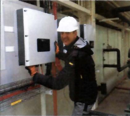
5; Instalación componentes parte alterna; En este tramo se conecta la planta al punto de conexión con los tableros ya elaborados. Se adjuntan fotografías:
