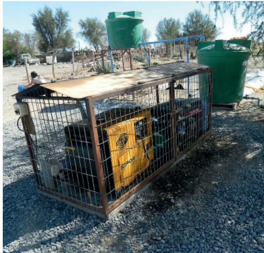
Figura 24. Sistema de generación de energía para el riego de las unidades aeropónicas y del sistema de nebulización del invernadero. Pozo Almonte.
