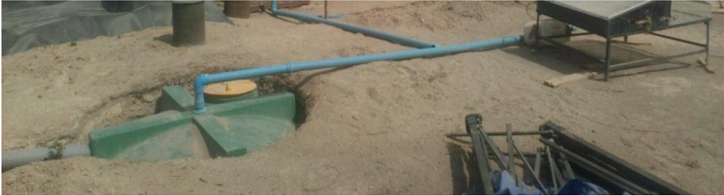
Figura 7. Estanque receptor del agua residual urbana tratada proveniente de la planta de tratamiento que ha pasado por el sistema de desbaste y decantación implementado por el proyecto. Pozo Almonte
