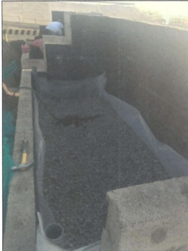
PASO N°6: Para separar el agua de mar y el sustrato, se utilizó una capa de malla anti-hierba y otra de malla Rachel, con la finalidad de que el sustrato no sature al espacio del movimiento del agua de mar.
