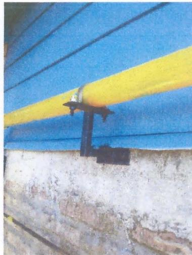
*En la fotografía se aprecia señal en tubería de entrada Biogás a grupo Electrónico y en exterior tubería protegida con pintura amarilla y filtro UV, es importante destacar que se instala con soportes resistentes y abrazaderas metálicas para evitar movimiento de la misma.*
