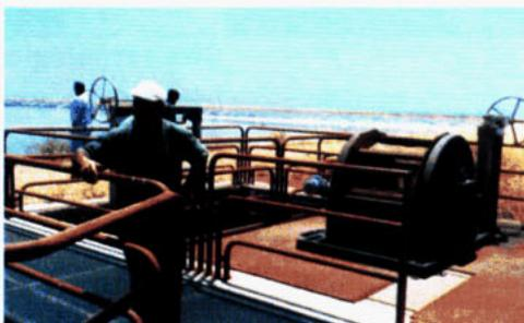
problema se ha solucionado haciendo un riego comunitario: se extrae agua desde el canal y se impulsa, mediante bombas, a un estanque de 75.000 m<sup>3</sup>; luego baja por gravedad a los predios de los agricultores. Cada agricultor maneja un contador, para conocer su consumo de agua. Con este sistema, se riegan 600 hectáreas en cinco pueblos.
