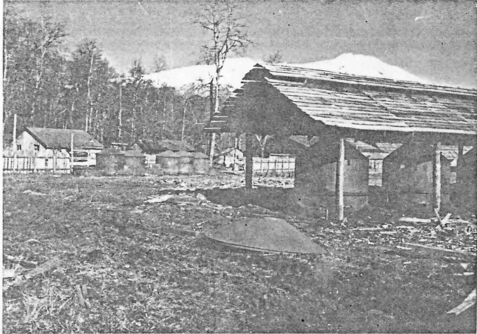
FIG. 3.2.12 Bateria de hornos MARK V en Neltume.
